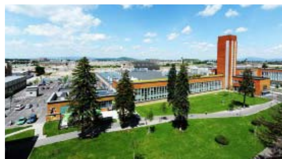
Строение: Coresi Business Park Страна: Румыния Город: Брасов Оборудование: VENTUS
