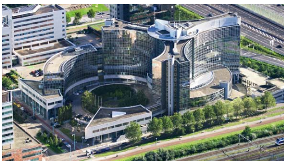
Строение: Park Inn Hotel Страна: Netherlands Город: Amsterdam Оборудование: VENTUS
