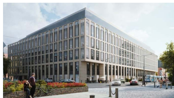
Строение: Nobilis Business House Страна: Польша Город: Вроцлав Оборудование: VENTUS
