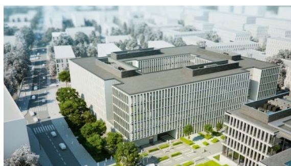
Строение: Office building Bobrowiecka 8 Страна: Poland Город: Warsaw Оборудование: VENTUS
