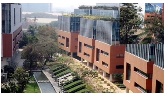
Строение: Morgan Stanley Страна: India Город: Mumbai Оборудование: VENTUS
