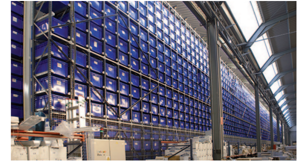
Строение: SECOM SA Страна: Rumunia Город: Chiajna Оборудование: WING
