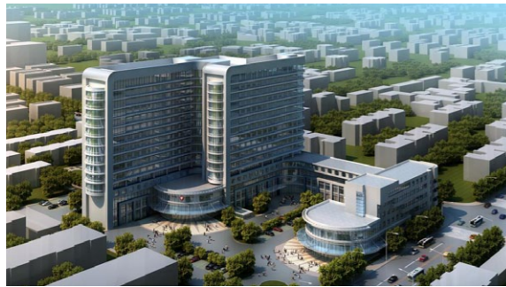
Строение: The traditional Chinese Medicine Hospital Страна: Chiny Город: Inner Mongolia, Hohhot Оборудование: VENTUS
