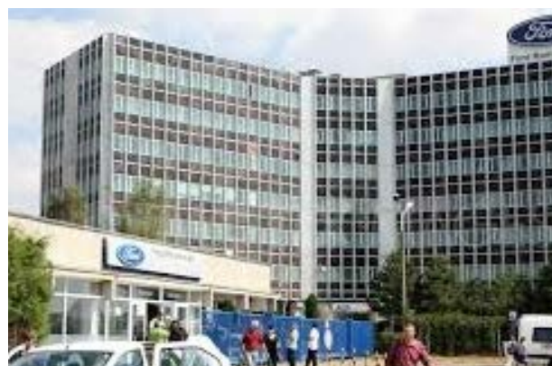
Название здания: Ford Production Area Страна: Румыния Город: Крайова
