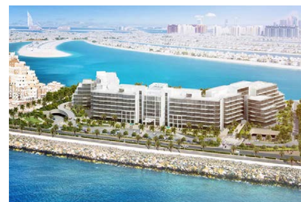
Название здания: C-14 Hotel Apartments Страна: ОАЭ Город: Дубай
