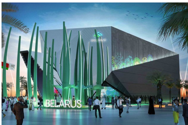
Nazwa budynku: BELARUS PAVILION Kraj: Zjednoczone Emiraty Arabskie Miasto: Dubai
