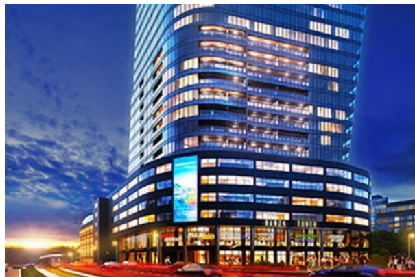
Nazwa budynku: Hanza Tower Kraj: Polska Miasto: Szczecin
