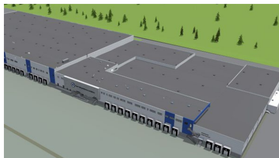
Nazwa budynku: ETK Logistic Center Kraj: Estonia Miasto: Tallinn Urządzenia: VENTUS
