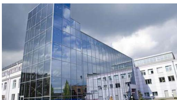
Nazwa budynku: Kondratievsky Business Center Kraj: Russia Miasto: Saint Petersburg Urządzenia: VENTUS
