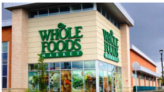
Nazwa budynku: Rollie Johnson Inc Kraj: USA Miasto: St. Louis Urządzenia: VENTUS
