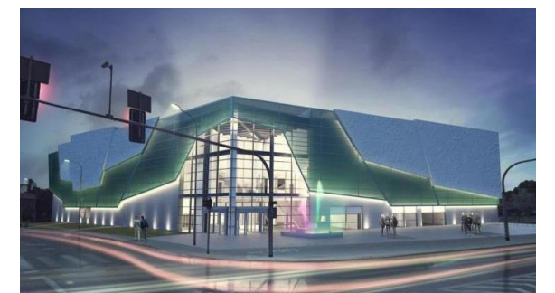
Nazwa budynku: Aquatics Center Kraj: Poland Miasto: Chełm Urządzenia: VENTUS
