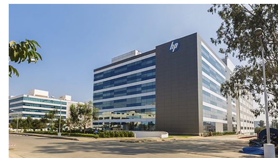
Nazwa budynku: Kalyani Tech Park - Magnolia Kraj: Indie Miasto: Bangalore Urządzenia: VENTUS
