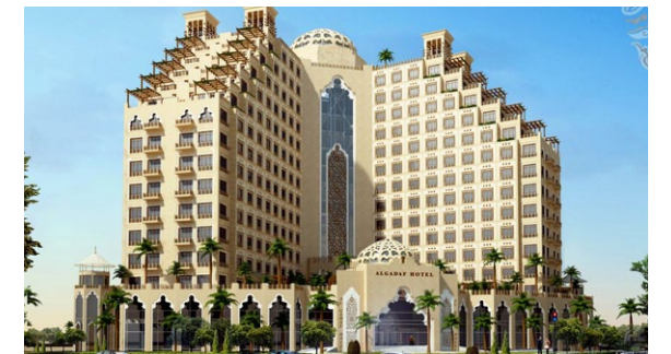
Nazwa budynku: Residential and Commercial building B+G+1P+12T in Al Jadaf Kraj: Dubai Miasto: UAE Urządzenia: VENTUS
