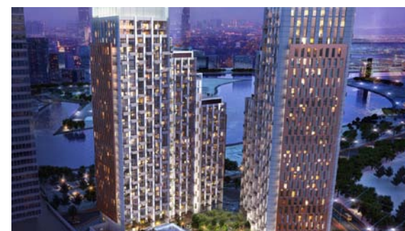
Nazwa budynku: The Atria Tower Kraj: UAE Miasto: Dubaj Urządzenia: VENTUS
