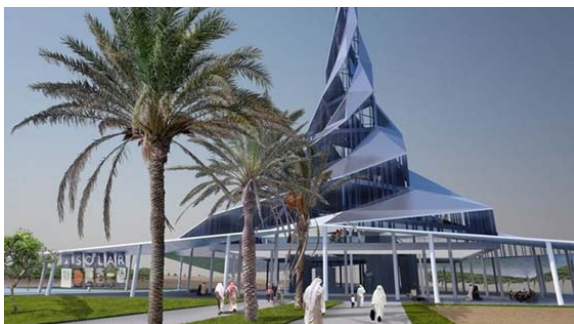
Nazwa budynku: DEWA Solar Innovation Center Kraj: UAE Miasto: Dubai Urządzenia: VENTUS
