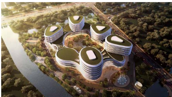
Nazwa budynku: Shanghai Wanhua International R&D Center Kraj: China Miasto: Shanghai Urządzenia: VENTUS
