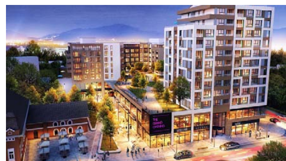
Nazwa budynku: Platina Malle Kraj: Rumunia Miasto: Cluj Napoca Urządzenia: VENTUS
