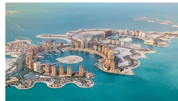
Nazwa budynku: Moon Island-Pearl Qatar Kraj: Qatar Miasto: Doha Urządzenia: American VENTUS
