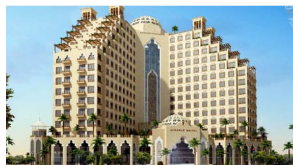
Nazwa budynku: Residential and Commercial building B+G+1P+12T in Al Jadaf Kraj: Dubai Miasto: UAE Urządzenia: VENTUS
