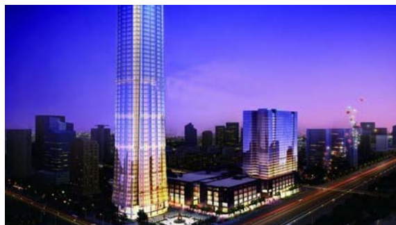
Nazwa budynku: Nanjing Sunny World Center Kraj: China Miasto: Beijing Urządzenia: VENTUS
