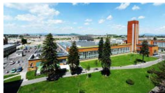
Nazwa budynku: Coresi Business Park Kraj: Romania Miasto: Brasov Urządzenia: VENTUS
