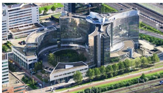
Nazwa budynku: Park Inn Hotel Kraj: Netherlands Miasto: Amsterdam Urządzenia: VENTUS
