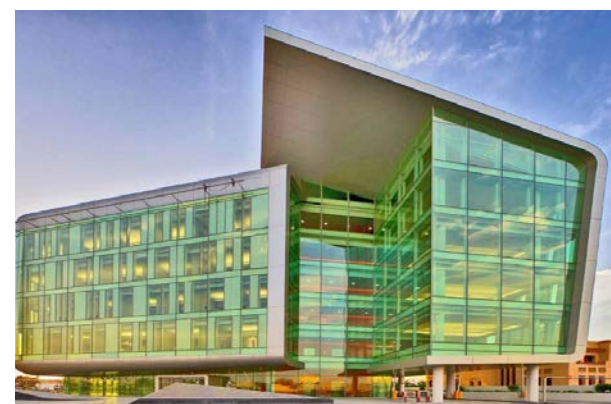
Nazwa budynku: Emirates Telecommunication Corp Kraj: UAE Miasto: Abu Dhabi
