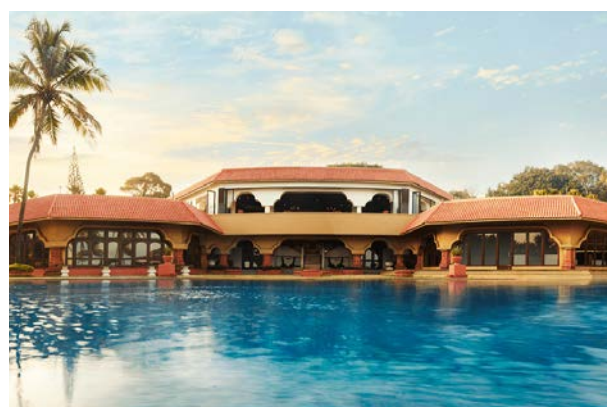
Nazwa budynku: Hermitage Centre, Taj Fabr Kraj: Indie Miasto: Goa
