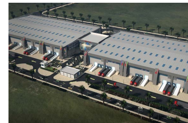
Nazwa budynku: Amazon Logistics Complex Kraj: UAE Miasto: Dubaj
