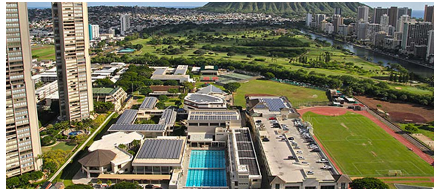
Nazwa budynku: Iolani School Campus Kraj: USA Miasto: Honolulu
