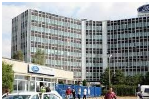
Nazwa budynku: Ford Production Area Kraj: Rumunia Miasto: Craiova
