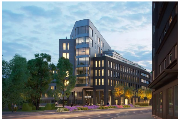
Nazwa budynku: Das Haus Residential and Commercial Center Kraj: Estonia Miasto: Talin
